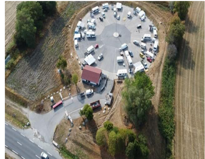
VIRY Aire a rénover 32 places
